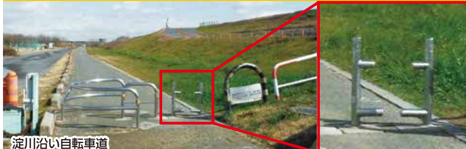
淀川沿い自転車道
