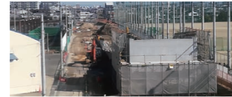
府道十三高槻線(正雀工区・末広工区) ～上部工を製作及び歩道整備～
